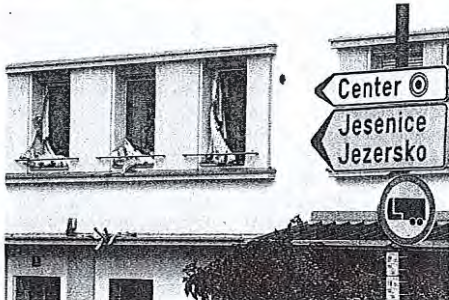
Vročina zaradi požara je bila tako velika, da so se stopile rolete in popokale šipe na bližnjih stavbah. / Foto: Gorazd Kavčič
