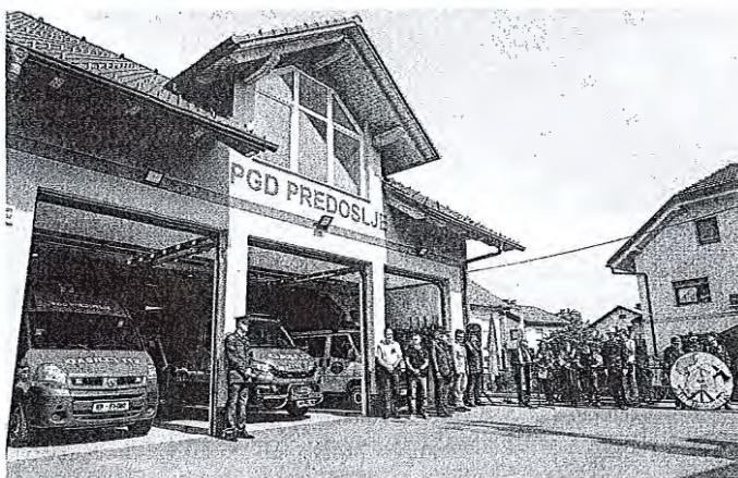
V dograjeni gasilski garaži v Predosljah je po novem prostora za tri vozila, dve več kot prej. / Foto: Tina Dokl
