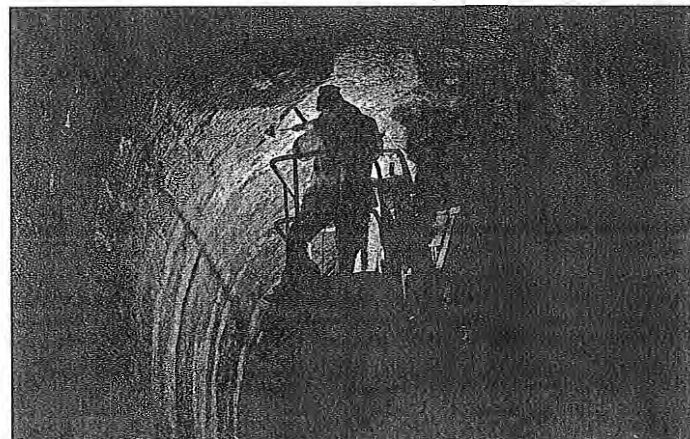
Zmagovalna fotografija na temo Posegi v prostor ob nadgradnji železniške proge je Obnova oboka v predoru Globoko, delo avtorja Vitomirja Pretnarja.
